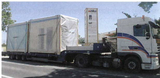
Transport des modules jusqu'au chantier
