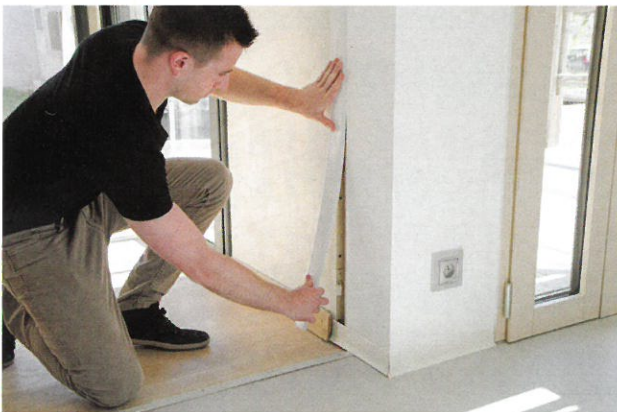
Réalisation des dernières finitions sur chantier
