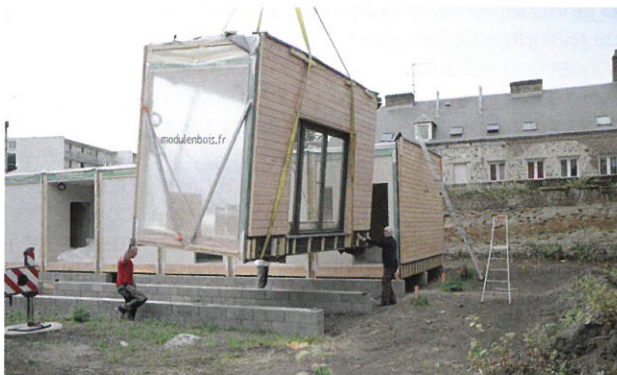
Installation sur les fondations et assemblage des modules
