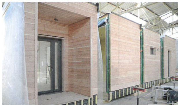
Préfabrication des modules en atelier
